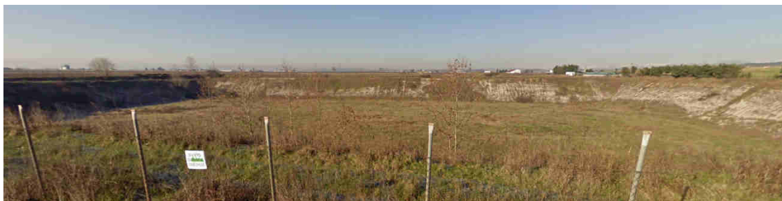
Figura 2.2: Stato di fatto
