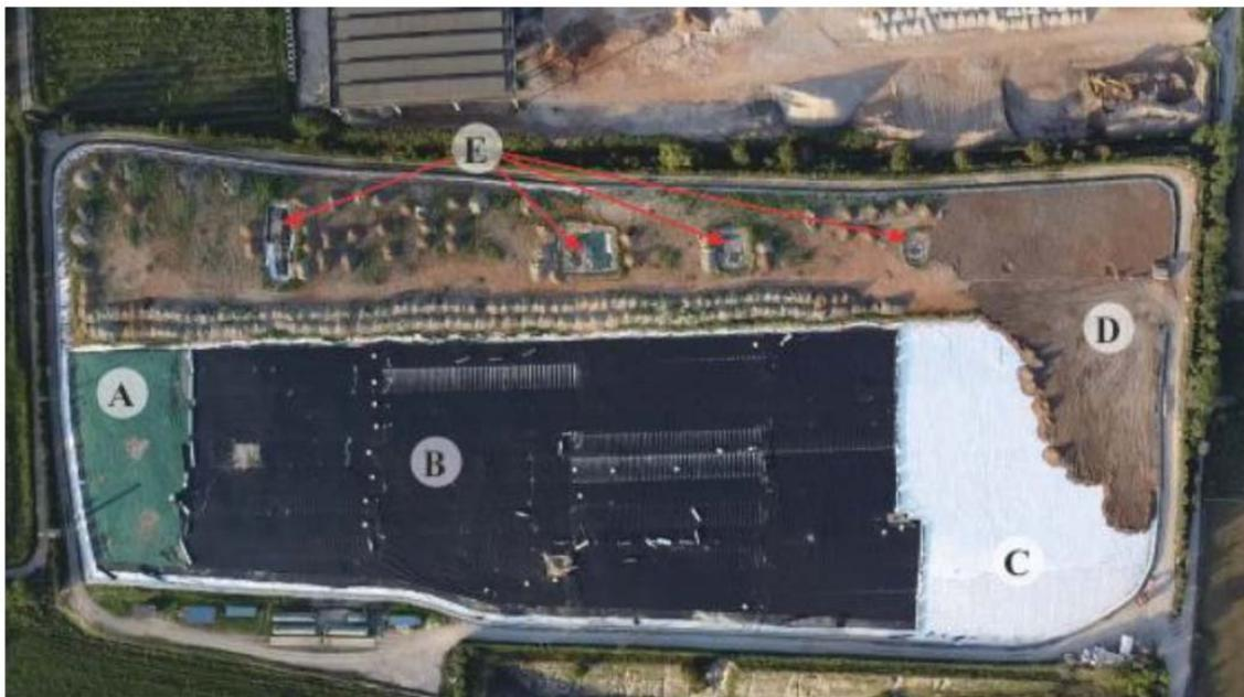
Fig. 4.1. Foto nel corso dei lavori di ribaulatura definitiva della discarica RSU, limitrofa al sito in esame. *A: stato iniziale, con copertura mediante teli impermeabili in LDPE; B: Stendimento geomembrane impermeabili in HDPE; C: Stesa Geocomposito Drenante; D: apporto e stendimento Terreno Vegetale; E: operazioni specialistiche in corrispondenza dei pozzi per la captazione del percolato.* (tratta da [12]).
