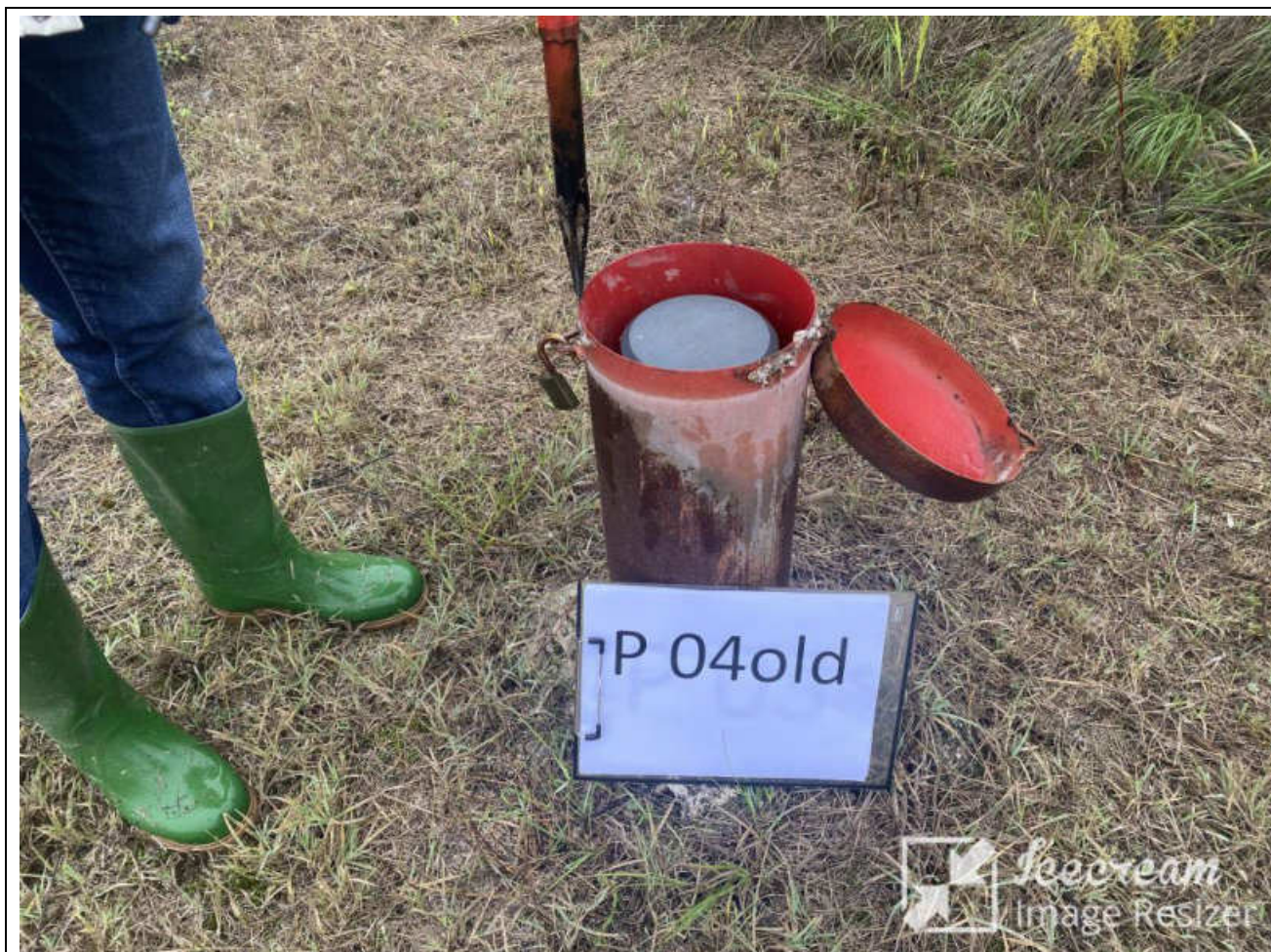
Fotografia Piezometro P 04 Old.
