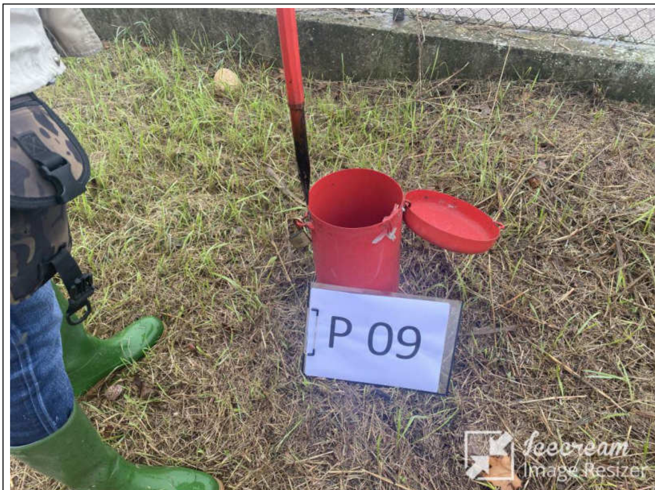
Fotografia Piezometro P 09.
